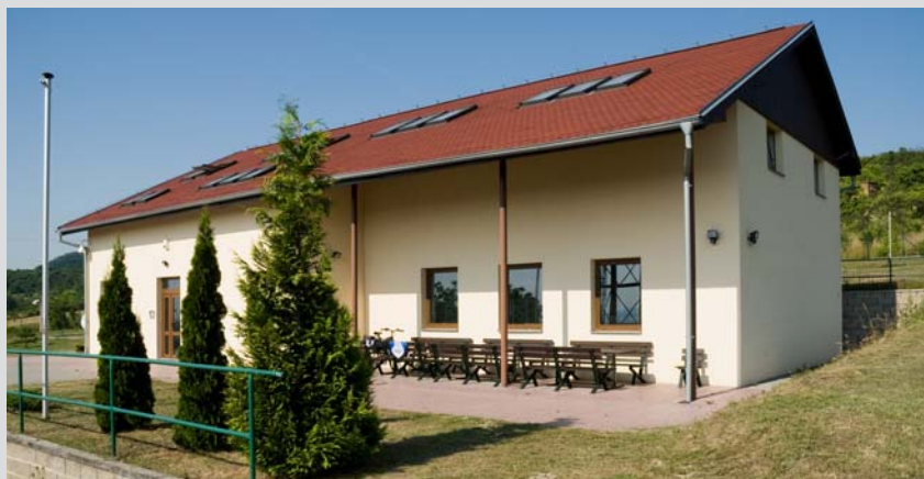
Administrativní budova – informační středisko.
