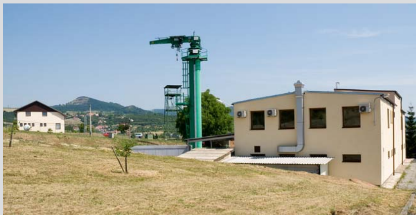
Jeřáb pro pádové zkoušky transportních obalových souborů.
