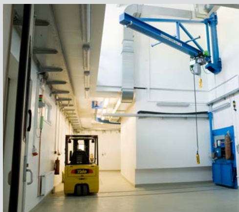
Hala provozní budovy.
